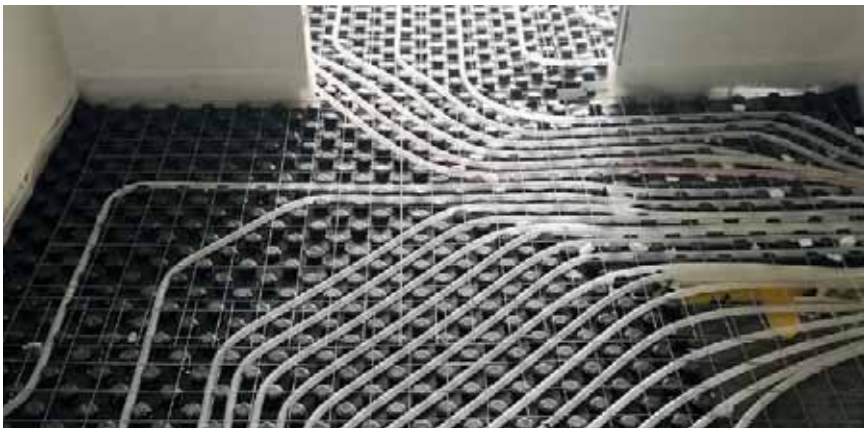
IMPIANTO A PANNELLI RADIANTI A PAVIMENTO
